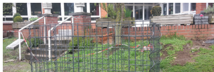
Foto: Unbefüllte Gabione für ein Hochbeet
