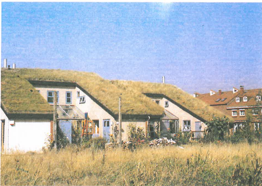
Gartenhofhäuser mit Grasdach
